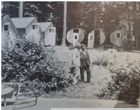
Vranovská přehrada - rekreační středisko s kapacitou 50 míst
