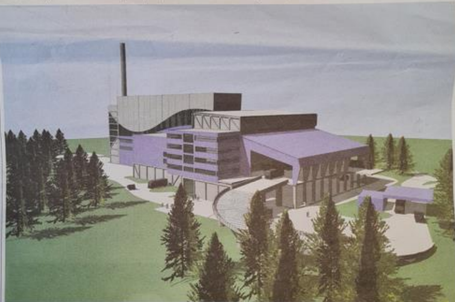
Odpad přemění na teplo. Zařízení na spalování odpadu s energetickým využitím by mělo pojmout 150 tisíc tun odpadu ročně. Připravuje se v Komofanech na Mostecku. Projekt dlouhé roky brzdila legislativa, nyní se díky novému zákonu dostalý přípravě do další fáze. Vizualizace: United Energy
